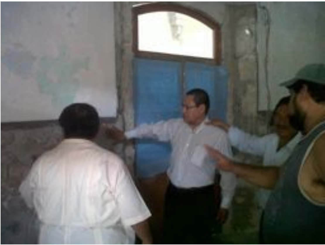
Supervisión de obras de remodelación del Palacio Municipal
